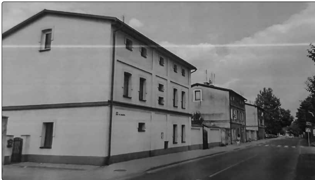
Il. 5. Domy robotnicze w Jaroszewcu. Zdjęcie Jacka Sypienia z jego artykułu „Przyfabryczne osiedla robotnicze na ziemi olkuskiej z przełomu XIX i XX wieku – pytania o przyszłość”.
