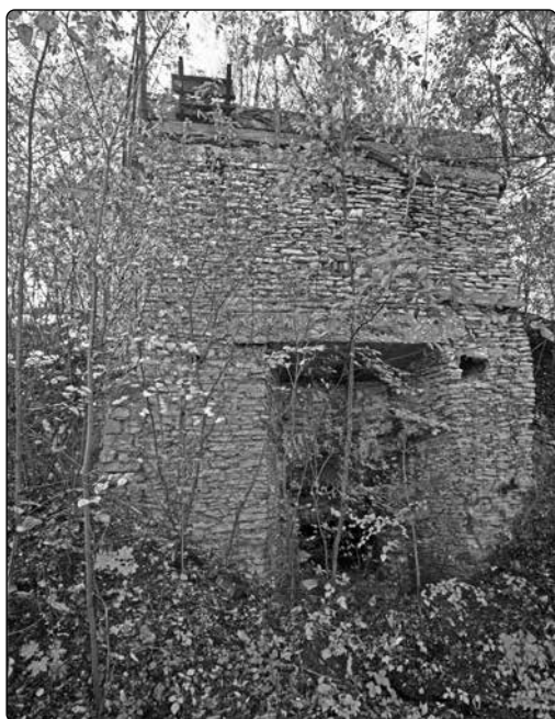
Il. 4. Opuszczony wapiennik przy ulicy Kamyk 12, zbudowany z kamienia wapiennego. Foto Grzegorz Onyszko.
